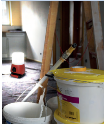
Renovierungsarbeiten 4000lm 360° Rundumlicht
